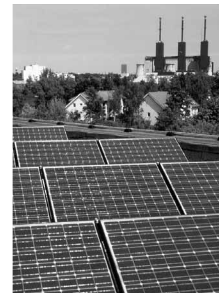
Solaranlage des Energieunternehmens Vattenfall auf dem Dach einer Berliner Schulsporthalle Foto: Vattenfall GmbH
